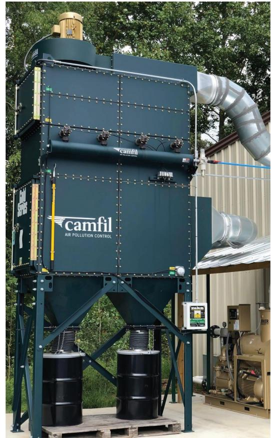
El captador de polvo de ocho cartuchos captura los humos de corte por láser de una aplicación automatizada de corte de tubos.
