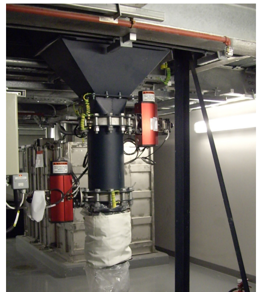
Der Endlossack wird am Austragssystem eingesetzt, um den während der automatischen Impulsreinigung des Abscheiders aus den Patronen freigesetzten Staub zu sammeln.
