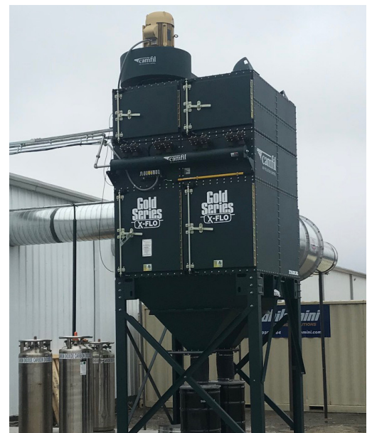
Der Gold Series X-Flo Trockenabscheider wird zur sicheren Erfassung von Schweißrauch direkt an der Entstehungsquelle eingesetzt. Ein integrierter Sicherheitsfilter ermöglicht die Rückführung der Luft ins Gebäude.
